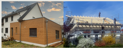
Anbau, Aufstockung, Dachgauben
