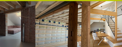
Scheunenausbau, Dachgeschossausbau, Umbau, Gebäudesanierung
