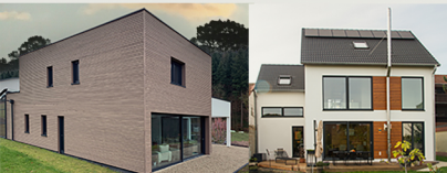
Neubau in Holzrahmenbauweise
